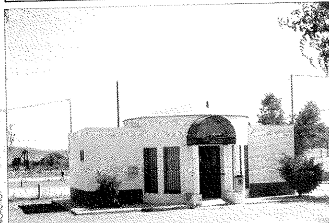
Consultorio del SAS. Al fondo, el pozo "María".
